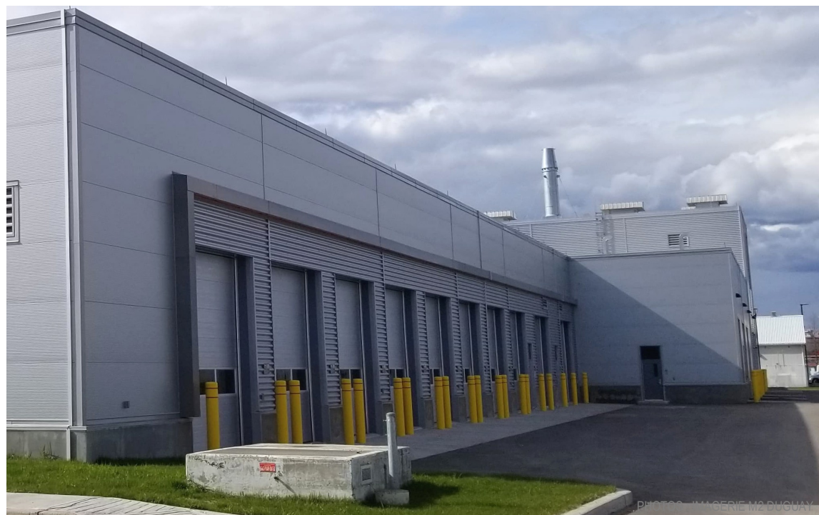
Les nombreux accès et les dimensions imposantes du bâtiment permettent d'y recevoir près de 70 véhicules pour l'entreposage ou les travaux de maintenance.
