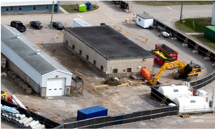
Les travaux de démolition des bâtiments 116 et 122 commenceront bientôt. Avant la fin de l'année, l'édifice 76 et le hangar 2 seront aussi déconstruits.
